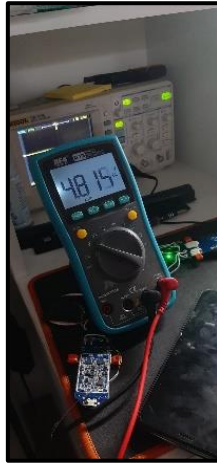
Ilustración 23: Medición del voltaje de salida con el multímetro
