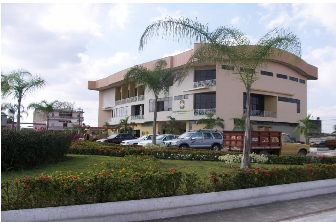
Foto 8. Palacio del GADM del Cantón EL Empalme.
