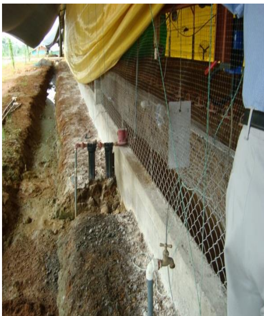
Zanjas de protección en galpones
