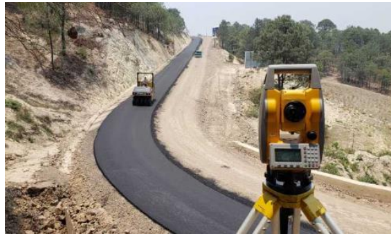
Ilustración 5. Topografía para vías de comunicación.
