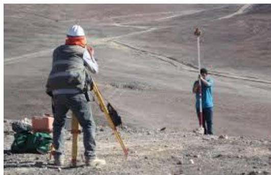
Ilustración 4. Levantamiento de terreno en general.
