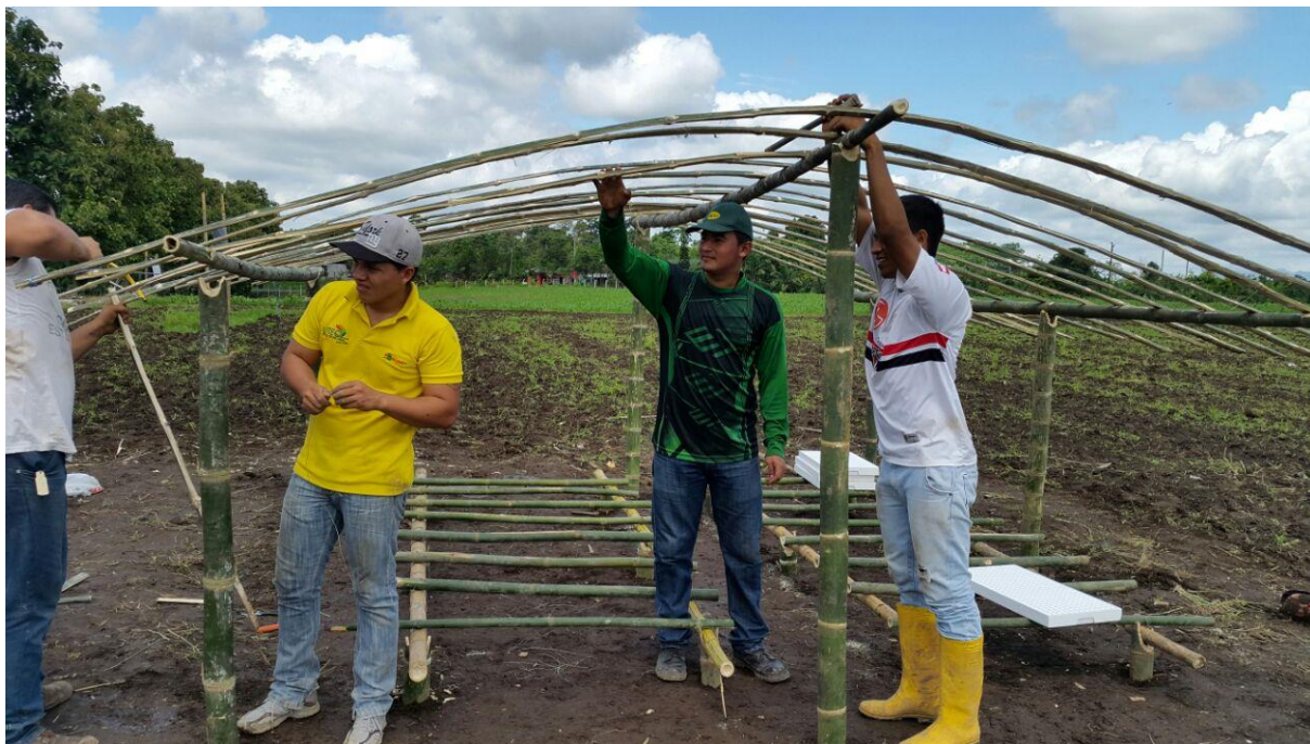
Anexo 1. Construcción de cubierta para semillero.
