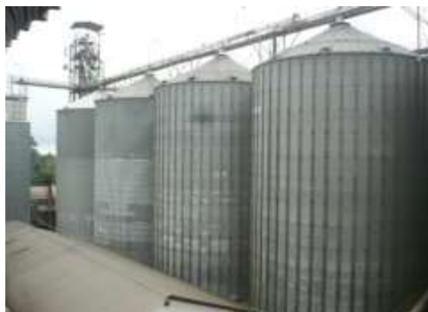
SILOS DE ALMACENAMIENTO
