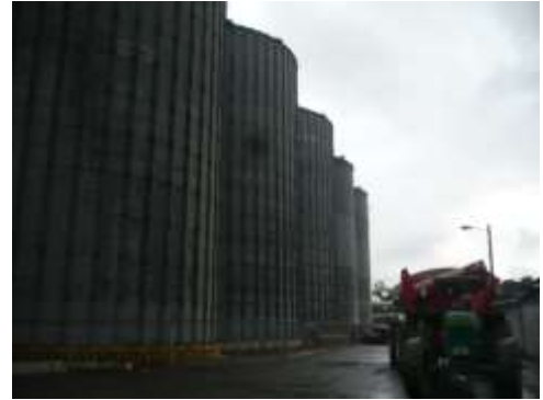
SILOS DE ALMACENAMIENTO
