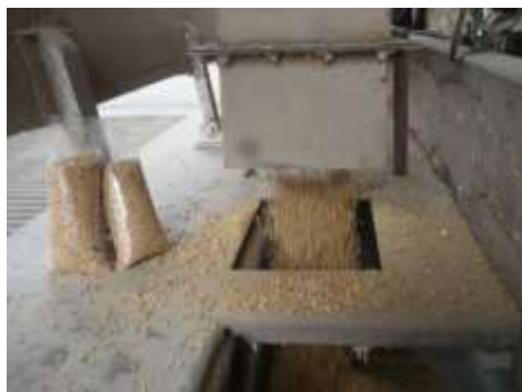
TRANSPORTADOR PARA LA SOYA TOSTADA
