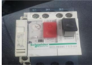
Figura 21 Disyuntor electrico
