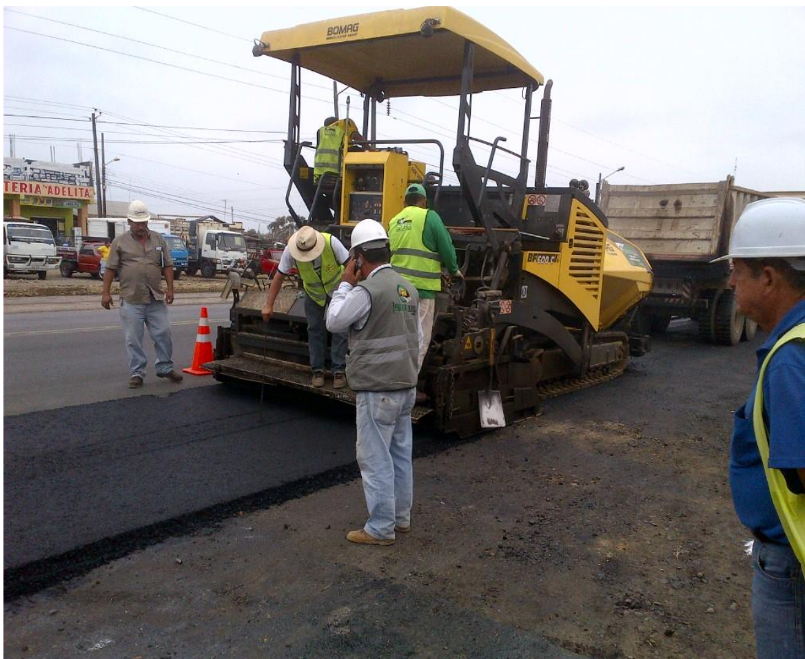
OBREROS Y FUNCIONARIOS EN PLENO PROCESO DE ASFALTADO EN LA AMPLIACION DE 4 CARRILES QUEVEDO – BUENA FE, PROVINCIA DE LOS RIOS.
