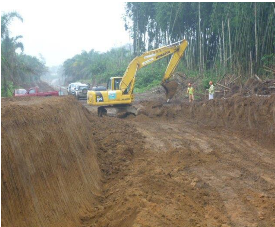
CONSTRUCCIÓN DE LA VIA ENTRE LAGOS TRAMO PLANTELSA – PUERTO PECHICHE – POZA HONDA DEL CANTON BUENA FE, PROVINCIA DE LOS RIOS.
