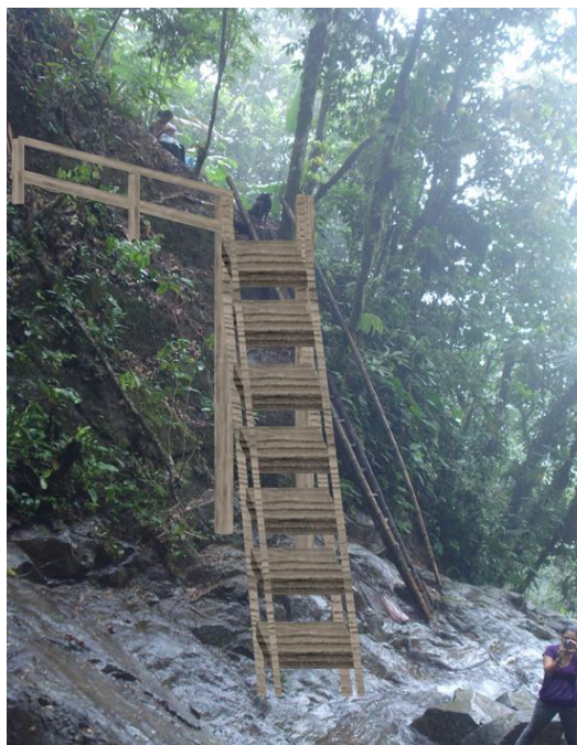
Figura 16. Barandas y escalera de seguridad.
