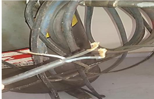
**Figura 22.** Compresor de tubo vertical LMEC-CPV-01 sin enchufe.
