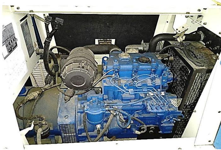
**Figura 33.** Suciedad en el interior del generador eléctrico.
