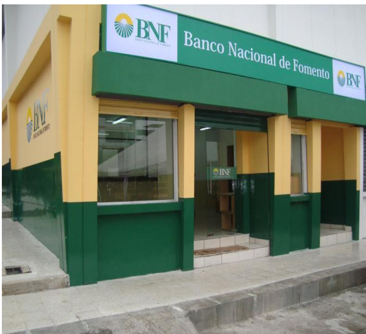
Figura 2. Instalaciones Banco Nacional de Fomento Sucursal El Empalme
