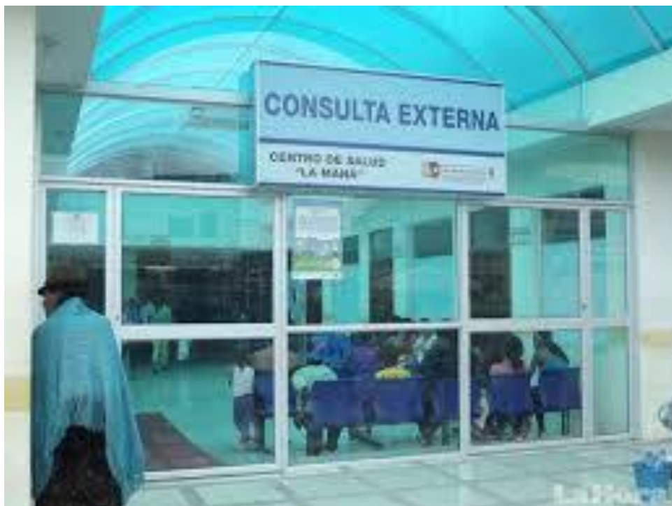
Entrada al Centro de Salud N° 5 de La Maná
