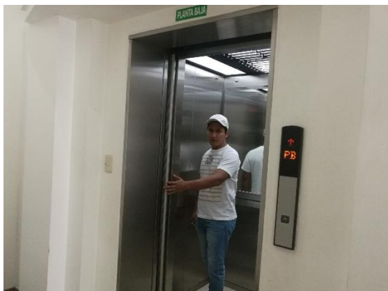
Imagen 13. Instalaciones accesibles para personas con discapacidad: ascensor en Grand Hotel La Maná.
