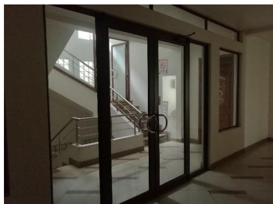
Imagen 16. Instalaciones accesibles para personas con discapacidad: puertas de acceso en Grand Hotel La Maná.
