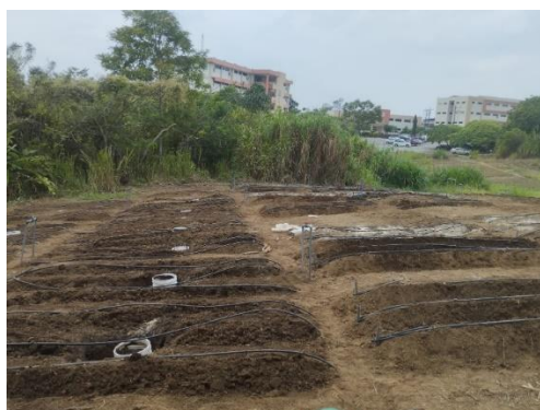
Anexo D. Instalación del sistema de riego.
