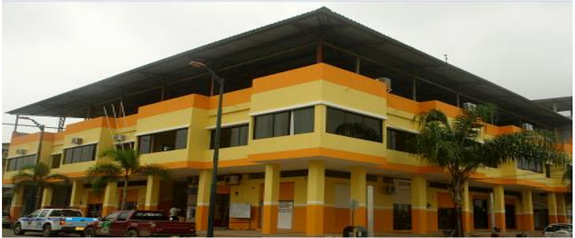
Gráfico 3. Infraestructura del GAD de Mocache
