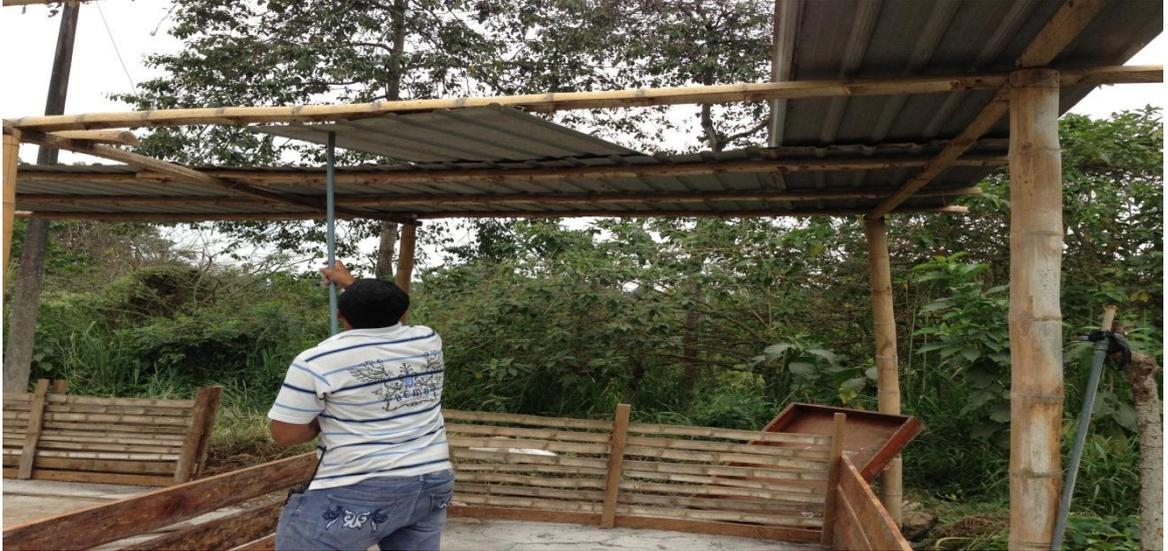
**Figura 1.** Construcción del Galpón
