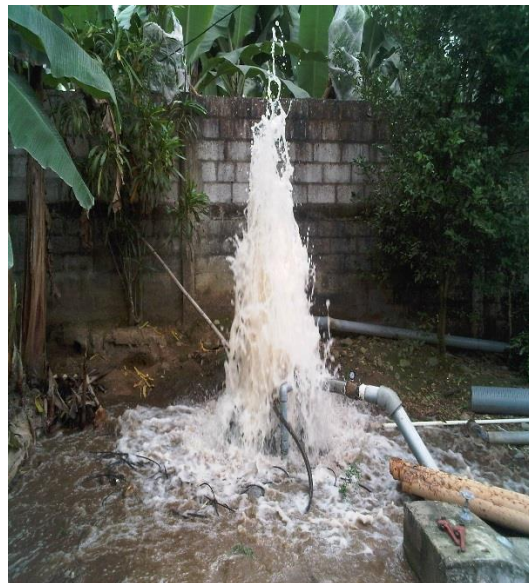
Limpieza y mantenimiento del pozo agua potable de Valencia no. 2
