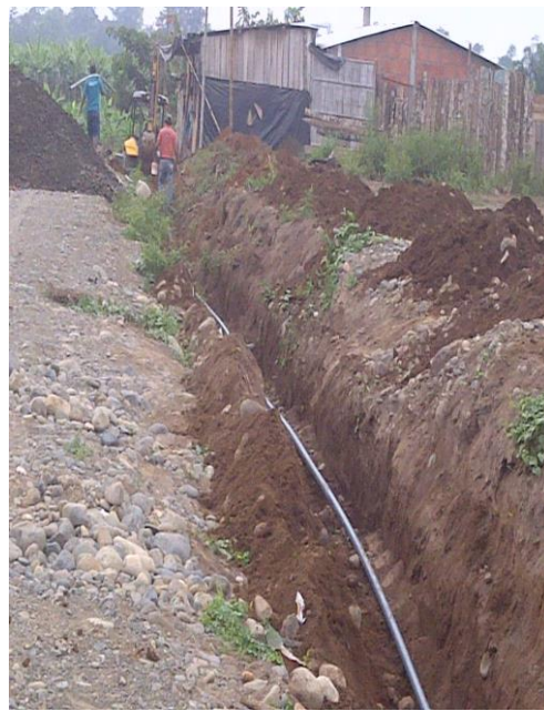
Labores de retroexcavadora para el tendido de red de agua potable, del Sector Chipe y Luis Felipe Díaz
