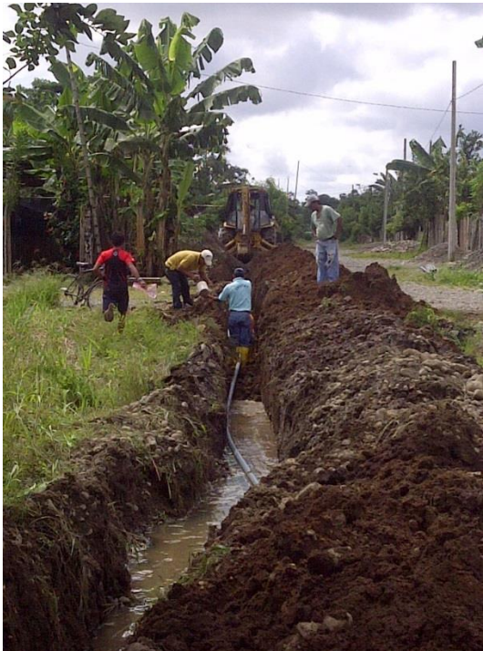
Ampliación de la red de agua de Calle Vaca Bonilla e instalación de una bomba de presión.
