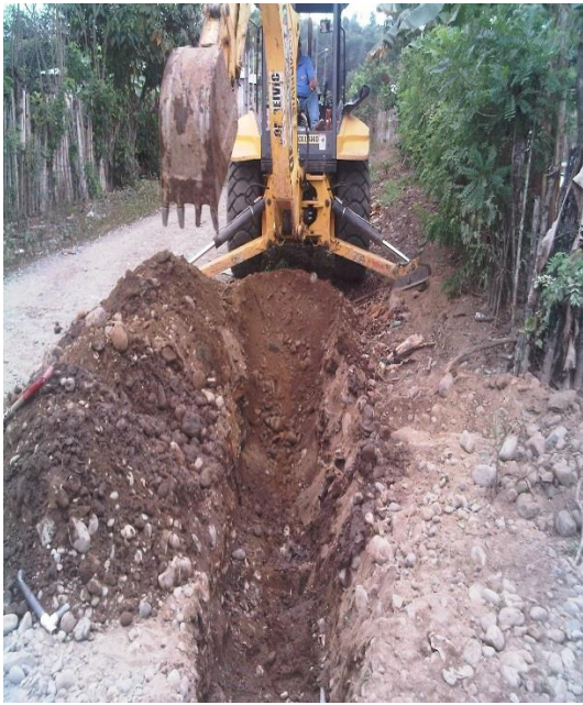
Labores de retroexcavadora para el tendido de red de agua potable, del Sector Chipe y Luis Felipe Díaz
