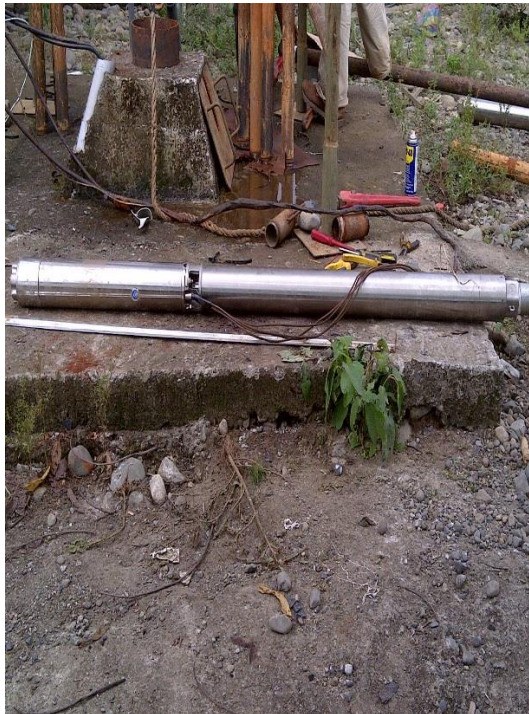
Ampliación de la red de agua de Calle Vaca Bonilla e instalación de una bomba de presión.
