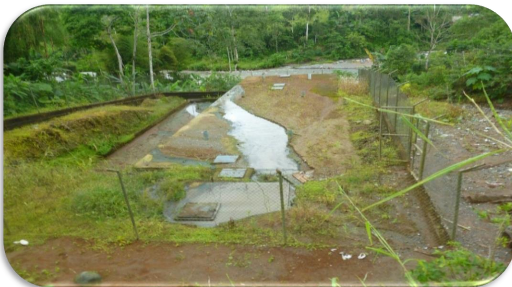
Figura No. 1.6. Planta de tratamiento de aguas residuales (1).
