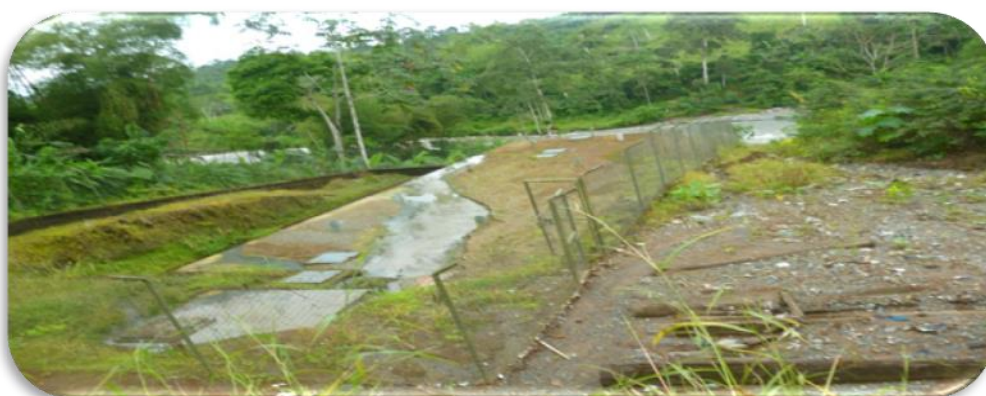
Fig.1.4. Planta de tratamiento de aguas residuales
