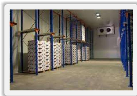
**Figura 14:** Cámara de frío para almacenamiento
