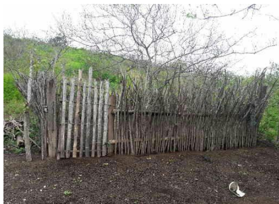
Instalación de madera
