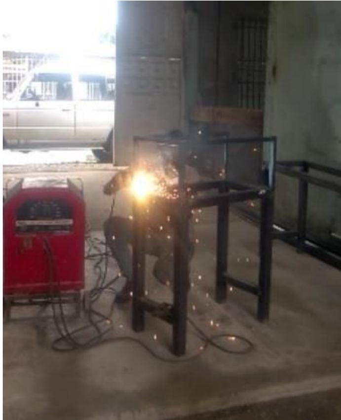
**Figura 32.** Soldando el cono que tendrá la función de separador de la caña.
