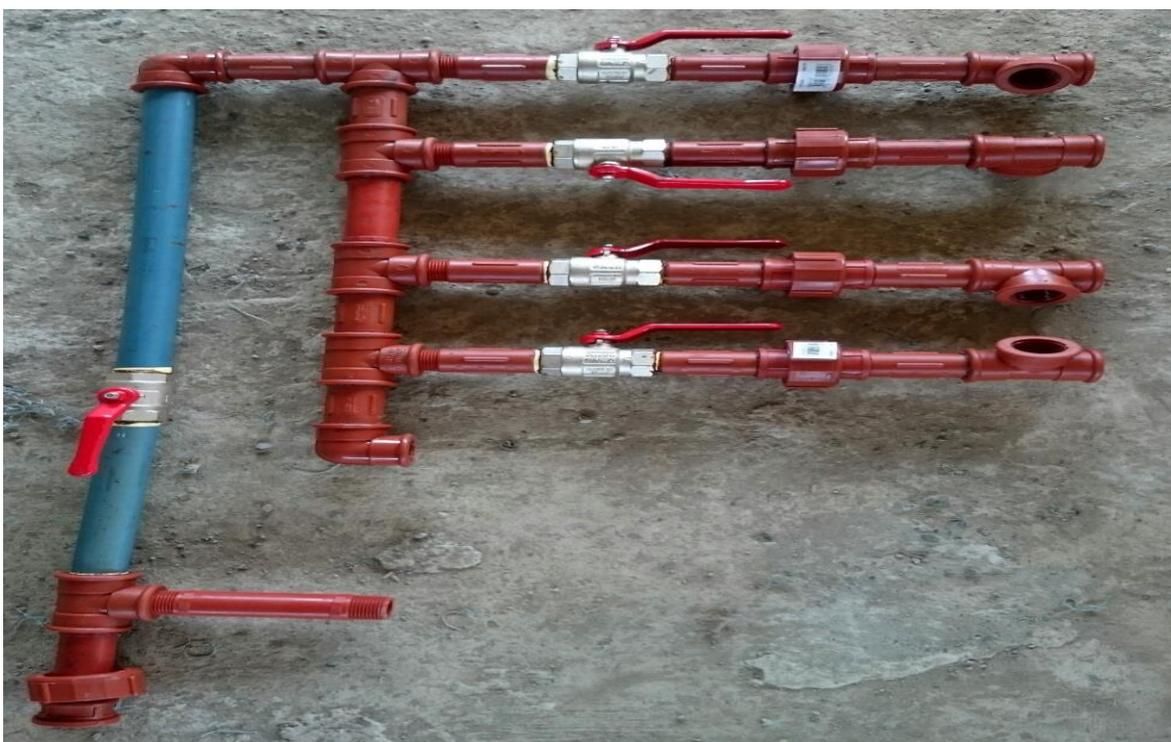
Fotografía N° 9. Montaje de los ramales al tablero principal
