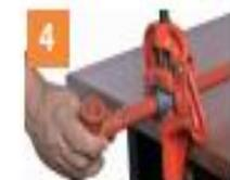
Prevea la limpieza de las roscas y compruebe en seco el roscado del tubo con el accesorio a instalar.
