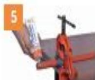
En la rosca macho del tubo aplicar una capa uniforme del sellador para rosca Línea agua caliente.
