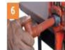
Efectuar el ajuste mediante presión manual del tubo con el accesorio.
