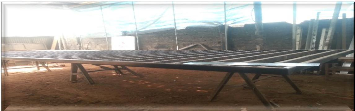
Después se colocan las denominadas cerchas, que darán su forma, dependiendo de las dimensiones requeridas; finalizada la estructura, continúa el frente y respaldo, se arma la estructura metálica con la forma de las partes delantera y trasera, donde se colocarán los frentes y respaldos prefabricados en fibra de vidrio.
