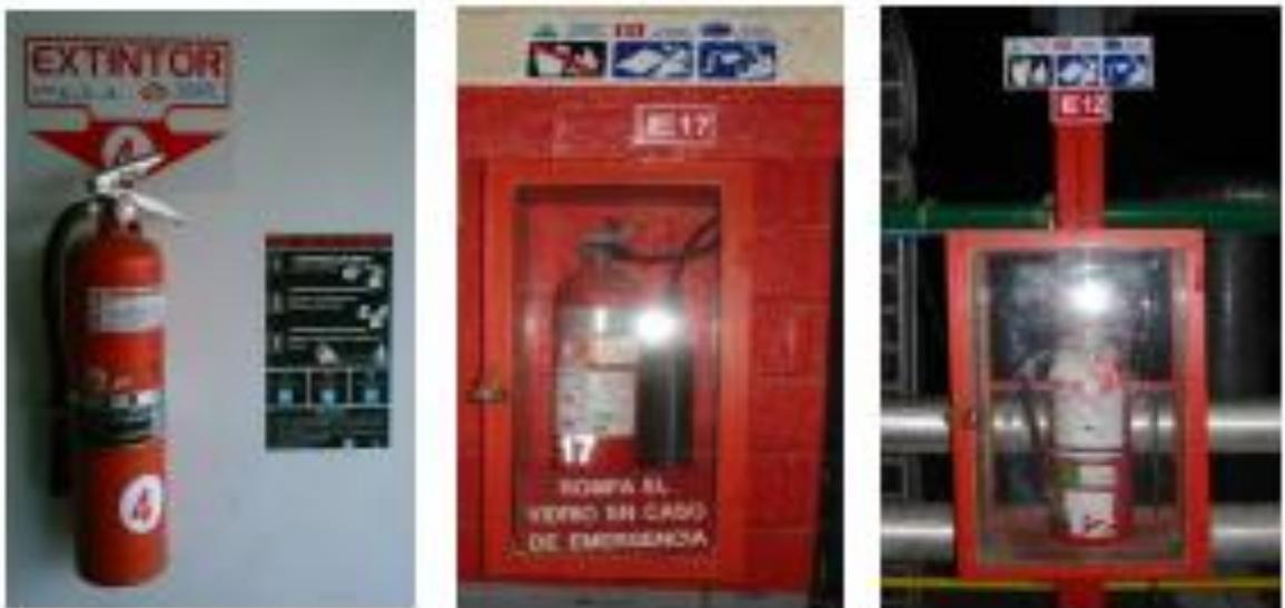
Figura 4. Instalación de extintores
